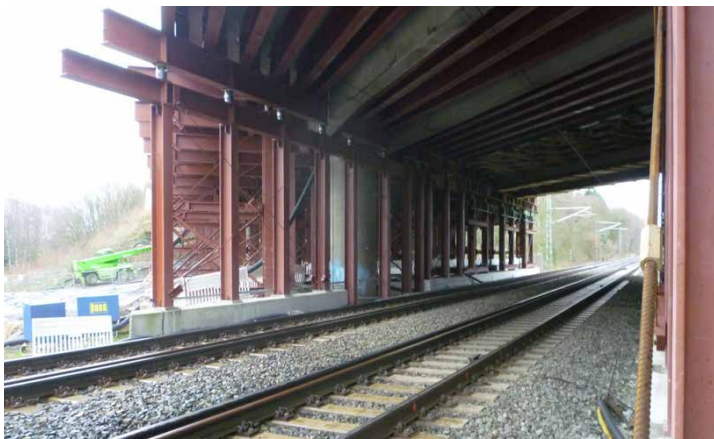
Das Traggerüst wurde mit Ultraschall überprüft, um die Tragfähigkeit zu sichern.
